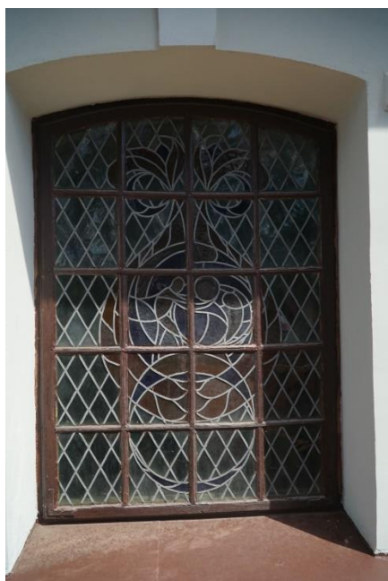
Zdjęcie nr 8.Parafia pw. Michała Archanioła. Nawa główna. Poziom +”0”.Widok z zewnątrz.
