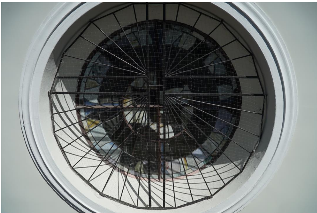
Zdjęcie nr 9. Parafia pw. Michała Archanioła. Kaplica południowa. Poziom +”0”. Widok z zewnątrz.
