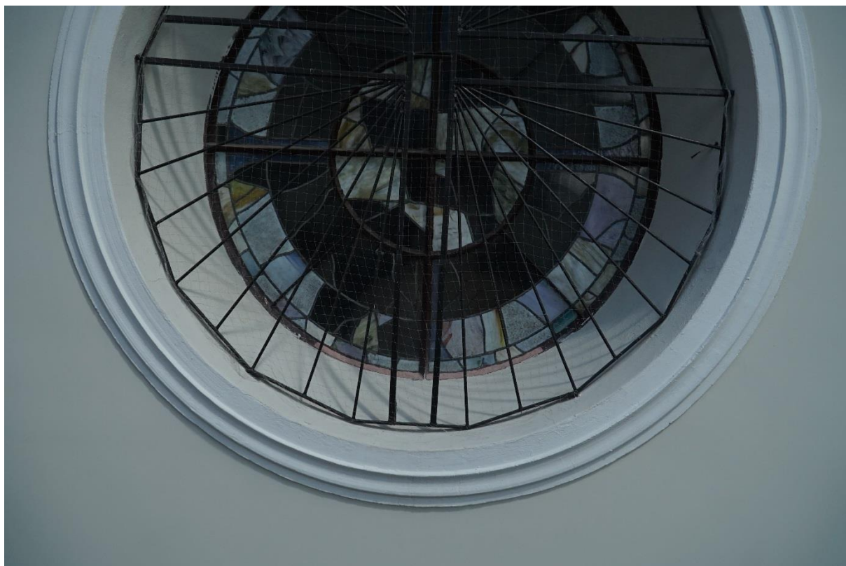
Okno okrągłe przed konserwacją
