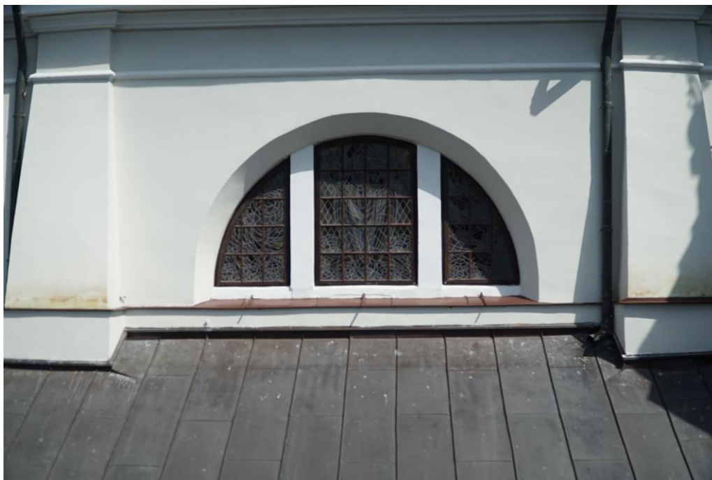
Zdjęcie nr 1. Parafia pw. Michała Archanioła. Nawa główna. Poziom +”1”.Widok z zewnątrz.
