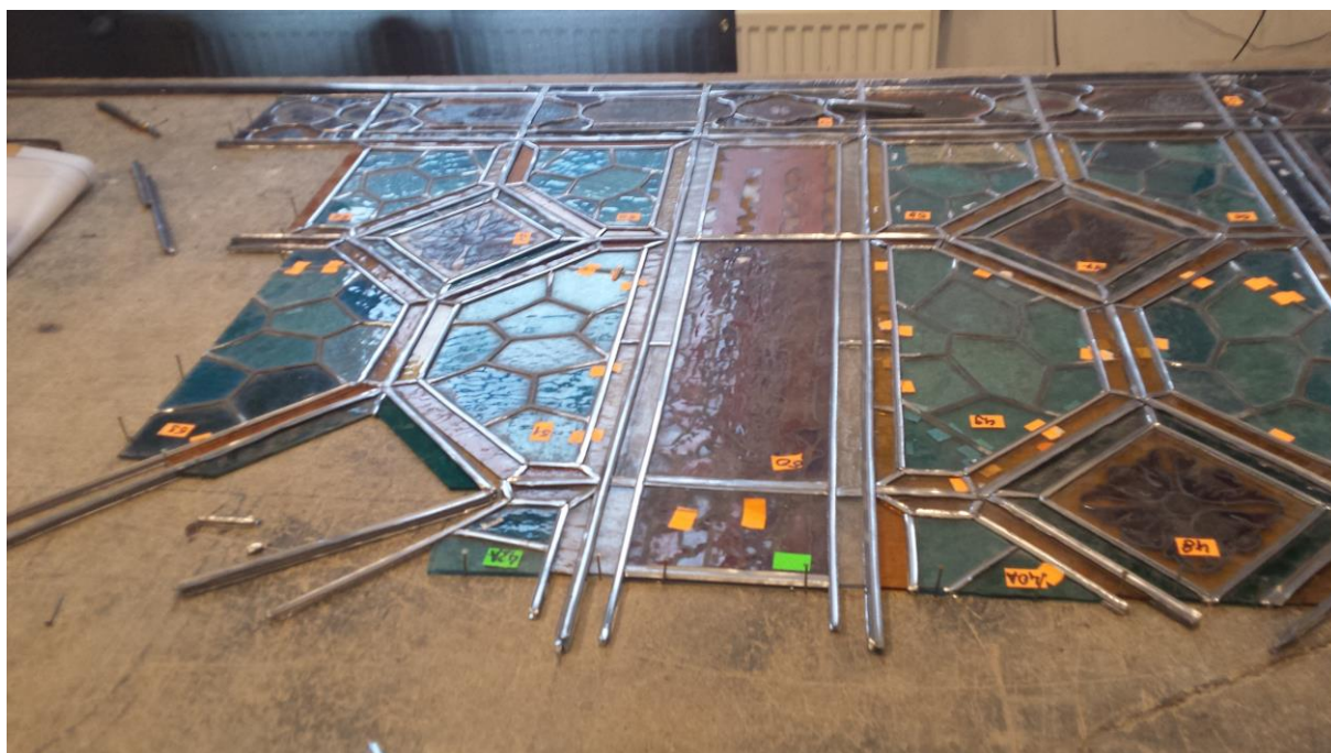
Zdjęcie nr 23. Parafia . Głusk – rozwiązanie nowych ujęć i oszkleń .Przygotowanie witraża pod nowe ujęcia
