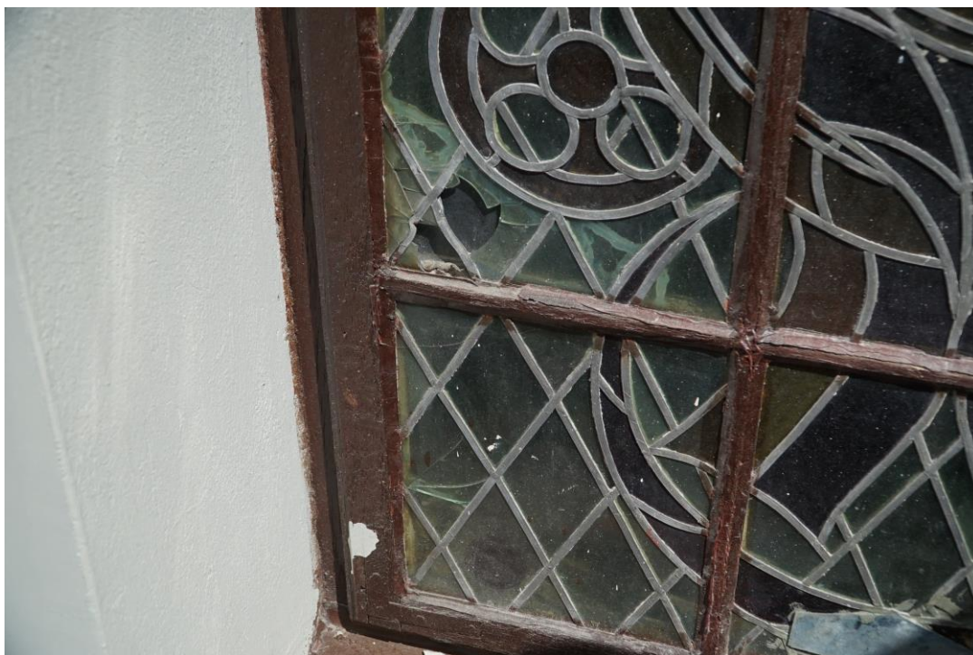
Zdjęcie nr 5. Parafia pw. Michała Archanioła. Nawa główna. Poziom +”1”.Widok z zewnątrz. Fragment.
