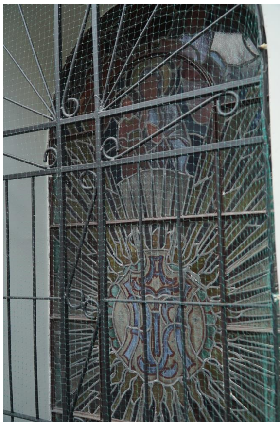
Zdjęcie nr 15. Parafia pw. Michała Archanioła. Kaplica południowa. Prezbiterium. Widok od zewnątrz.
