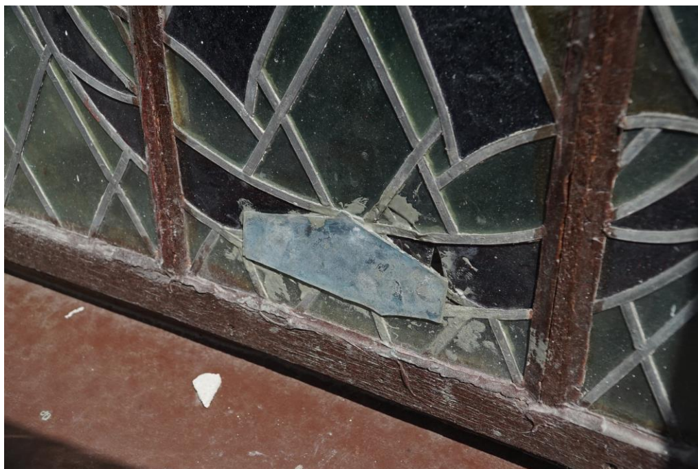
Zdjęcie nr 3. Parafia pw. Michała Archanioła. Nawa główna. Poziom +”1”.Widok z zewnątrz. Fragment.
