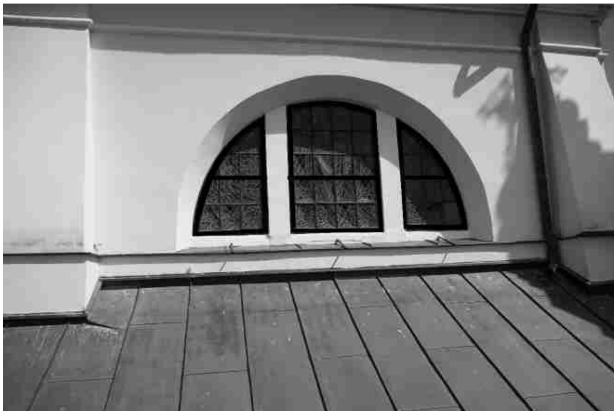
Okno po konserwacji wraz ze szkleniem osłonowym
