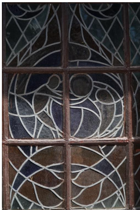
Zdjęcie nr 7 .Parafia pw. Michała Archanioła. Nawa główna. Poziom +”0”.Widok z zewnątrz.Fragment.
