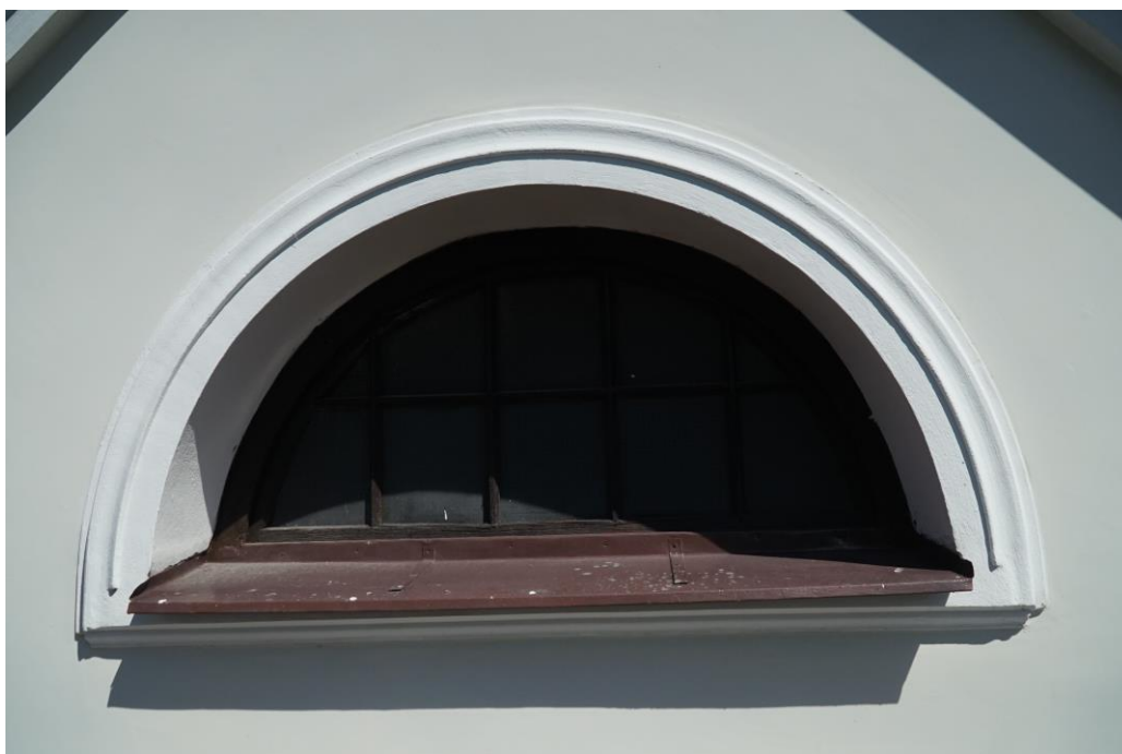
Zdjęcie nr 10. Parafia pw. Michała Archanioła. Kaplica południowa. Poziom +”1”. Widok z zewnątrz.
