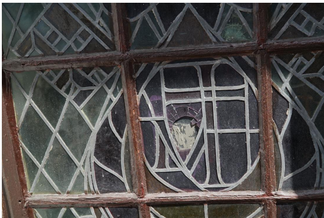
Zdjęcie nr 4. Parafia pw. Michała Archanioła. Nawa główna. Poziom +”1”.Widok z zewnątrz. Fragment.
